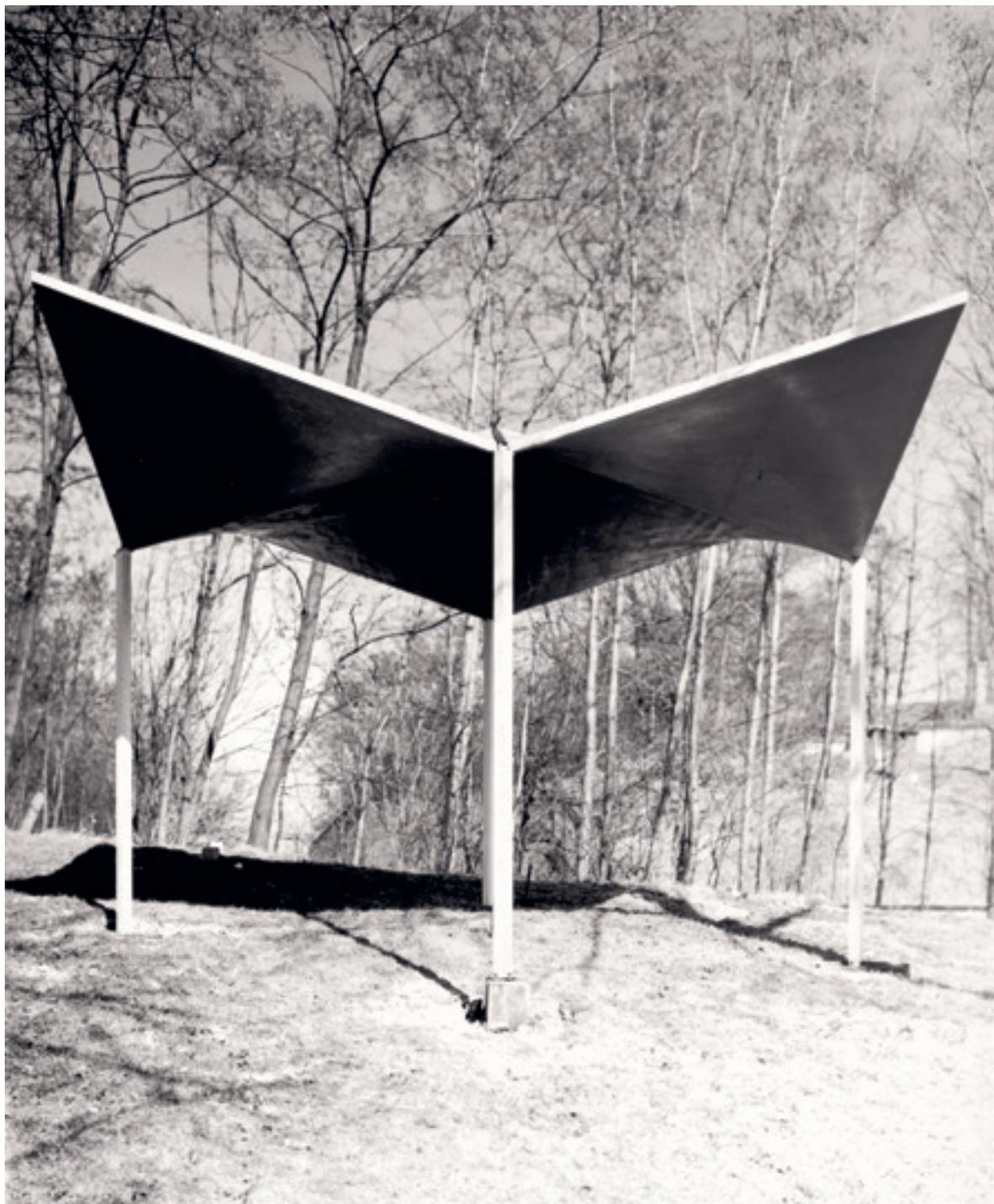
in zwei Dimensionen reißbare Struktur aus hyperbolisches Paraboloiden von maximalem Transportmaß 240 x 240 cm (Prototyp Ulm). Entwurfs team: Doornick, Bartholdy, Förschilling, Herbst, Matzek, Pfromm, Ramstein, Wurm.
