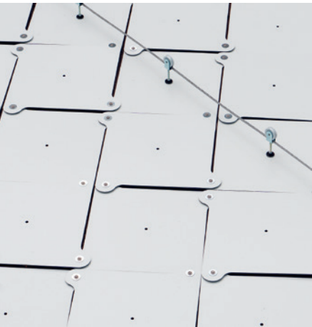
Projekt „Butterfly“: wandelbare metal- lische Leichtbaustruktur mit neuartigem Öffnungsmechanismus. Project “Butterfly”: convertible lightweight metal structure with novel opening mechanism.
