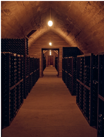
Neuer Weinkeller „Chai“ mit „Baustellenbeton“ aus Stampflehm mit sehr geringen Anteilen an Wasser und weißem Zement. New wine cellar “chai” with “site concrete” made of rammed earth containing very little water and white cement.
