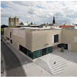
LWL-Museum für Kunst und Kultur, Münster Staab Architekten GmbH, Berlin Space4 GmbH, Stuttgart LDE Belzner Holmes, Stuttgart fertiggestellt 2014 LWL-Museum für Kunst und Kultur, Münster Staab Architekten GmbH, Berlin Space4 GmbH, Stuttgart LDE Belzner Holmes, Stuttgart completed in 2014
