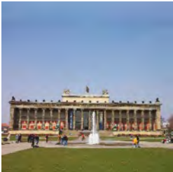
Generalsanierung Altes Museum, Berlin Hilmer & Sattler und Albrecht GmbH, Berlin in Bearbeitung General Refurbishment of the Altes Museum, Berlin Hilmer & Sattler und Albrecht GmbH, Berlin work in progress
