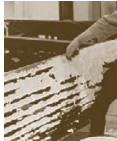
1/2 Gipsauftrag plaster application
