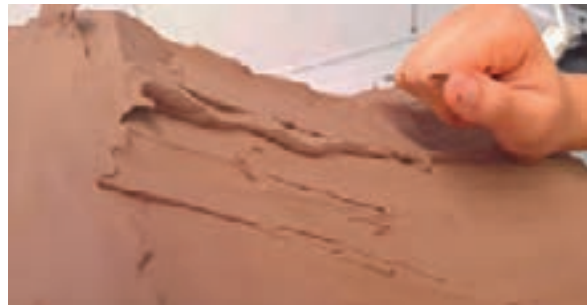
3.2/10 Richtig: Mit dem Handballen nach oben bei gleichmäßigem Druck
