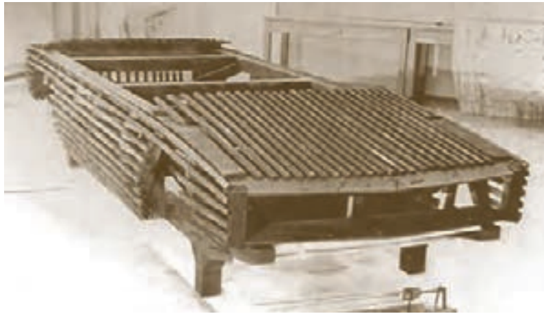
1/1 Einfache Holzlatten dienten beim Gipsmodell als Unterbau. Simple wooden slats served as a substructure for the plaster model.
