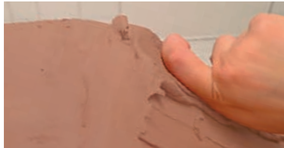
3.2/9 Richtig: mit angewinkeltem Zeigefinger fließend nach unten aufclayen
